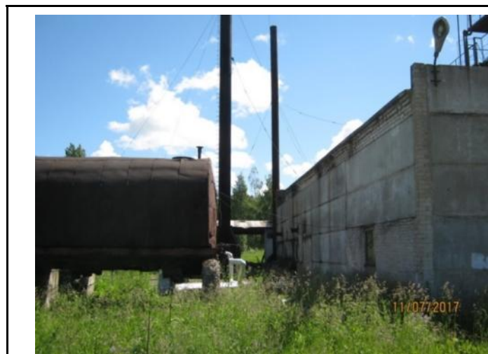
Рисунок 1.2.1. – Здание и баки котельной № 1
