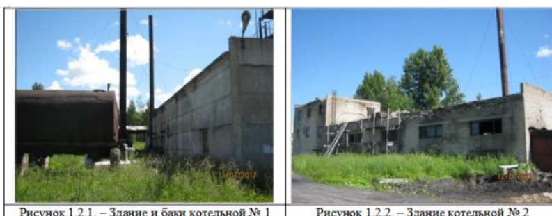
Рисунок 1.2.1. – Здание и баки котельной № 1
