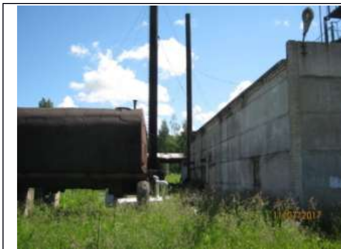
Рисунок 1.2.1. – Здание и баки котельной № 1
