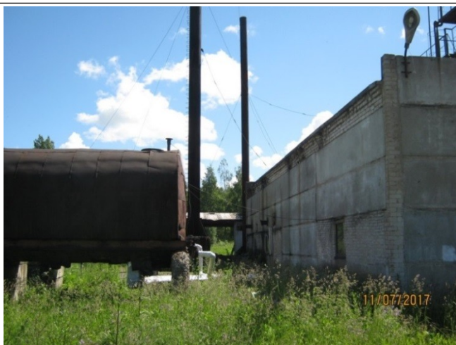
Рисунок 1.2.1. – Здание и баки котельной № 1
