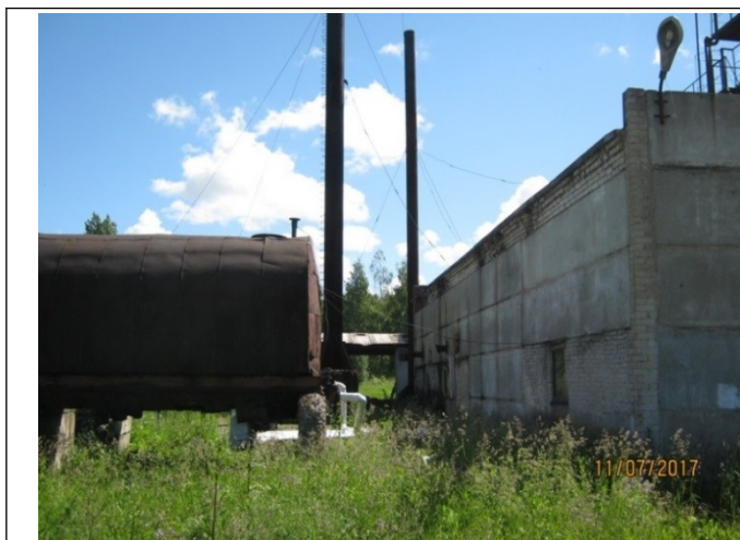
Рисунок 1.2.1. – Здание и баки котельной № 1
