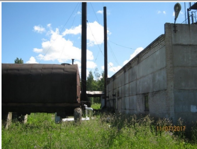
Рисунок 1.2.1. – Здание и баки котельной № 1
