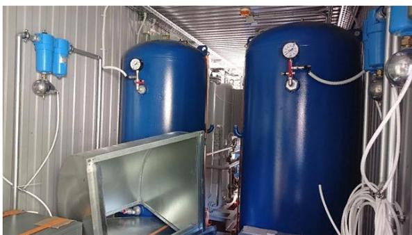
Станция в Галичской окружной больнице способна вырабатывать около 1000 литров кислорода в час. Здесь установлено два компрессора. Один будет находиться в резерве. В случаях пиковых нагрузок они могут работать одновременно. В зоне обслуживания Галичской окружной больницы — пациенты из пяти муниципальных образований Костромской области — Галичского, Антроповского, Нейского, Чухломского, Парфеньевского районов. Во время пандемии здесь
